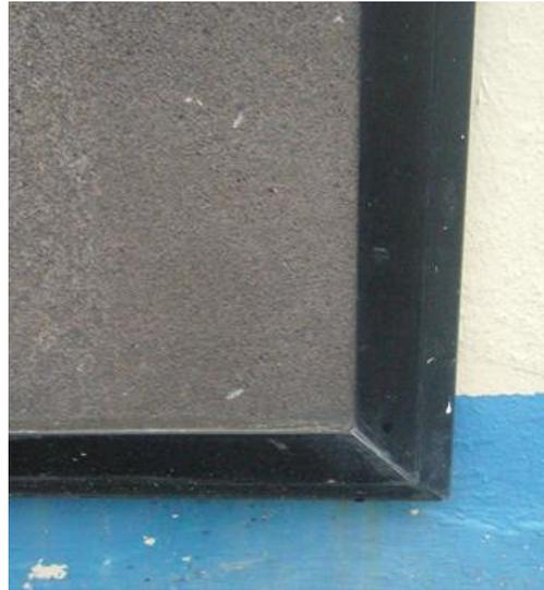
Mise en place d'un contour en métal de protection tout autour de la fresque extérieur avec rivet entre quatre plaques.
